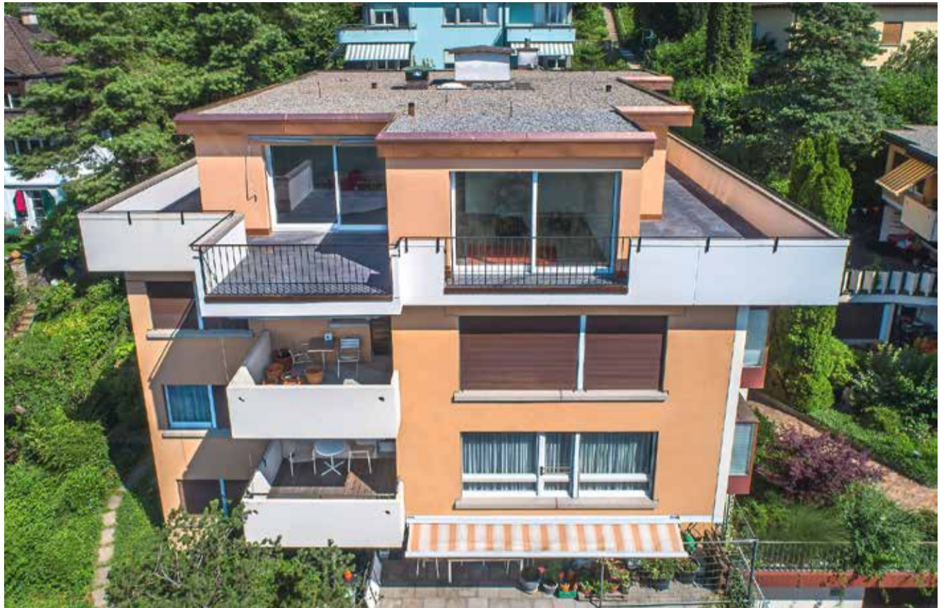
Die orange-beige Farbgebung des 1970er-Jahr-Mehrfamilienhauses wurde auch für die neuen Bauteile übernommen. Dadurch fügt sich die erweiterte Attikawohnung immer noch gut in die bestehende Architektur ein. BILD HUMMELFLUG
